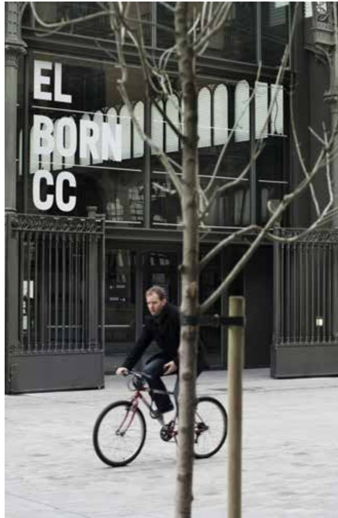
El centro ocupa el antiguo mercado central, emblema de la arquitectura del hierro
