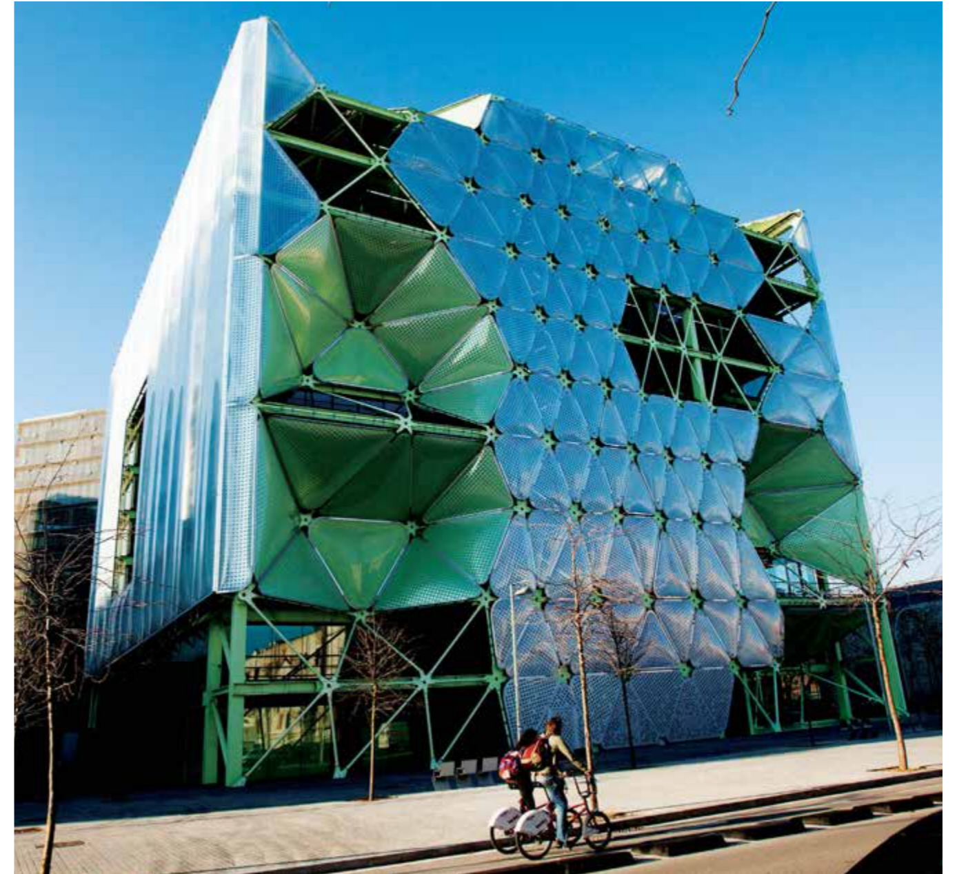
L'Oficina d'Atenció a l'Empresa es troba a l'edifici Barcelona Growth Centre
